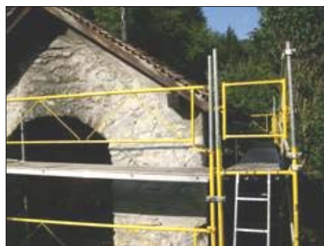
L'échafaudage ceinture l'ouvrage pour une garantie de sécurité
