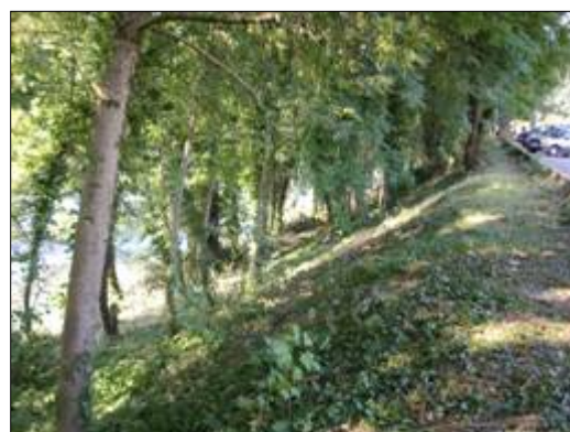
PONT DE TASSET Résultat final après nettoyage, tronçonnage et débroussaillage
