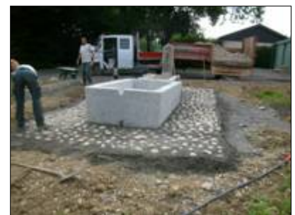
CABANE DES CHASSEURS Pose de dalle avec pavés, pose de bordure et création de mobilier
