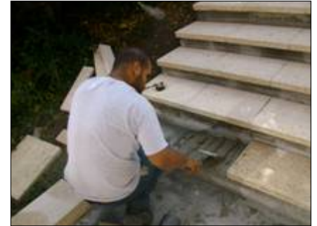
ECOLE PRIMAIRE DE VIRY Réfection des marches d'escalier (du coffrage jusqu'à la pose de dalles) en prévention des risques pour les écoliers
