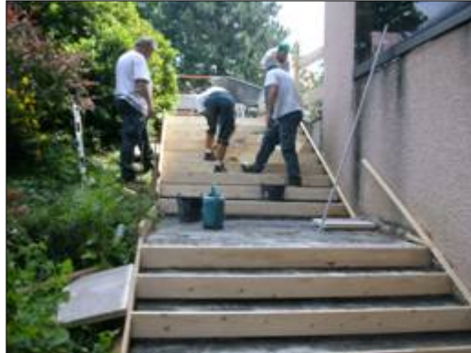
ECOLE PRIMAIRE DE VIRY Réfection des marches d'escalier (du coffrage jusqu'à la pose de dalles) en prévention des risques pour les écoliers
